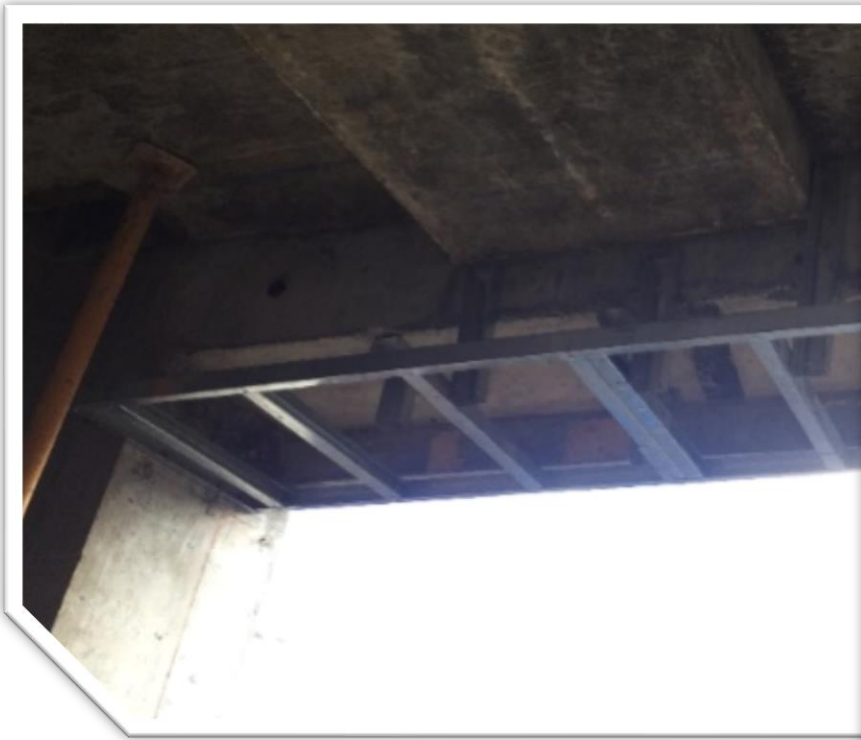
Montaje seriado de estructura
