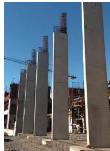
Pilares prefabricados en obra
