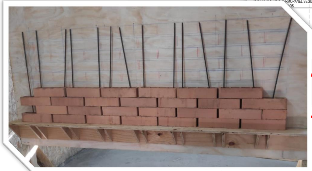
Mesa de trabajo para fabricación de panel Dintel
