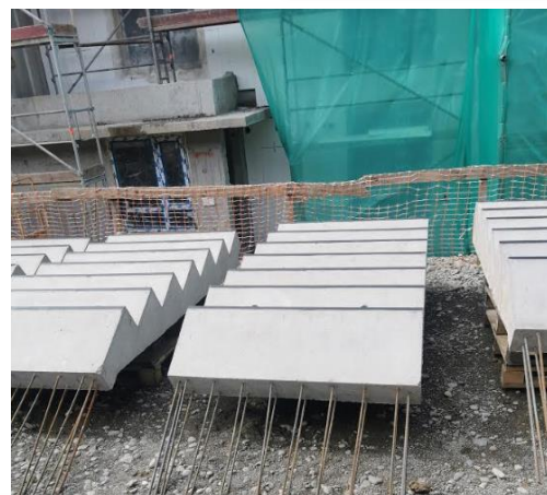
Escalas prefabricadas en obra
