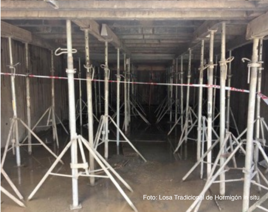
Foto: Losa Tradicional de Hormigón in situ
