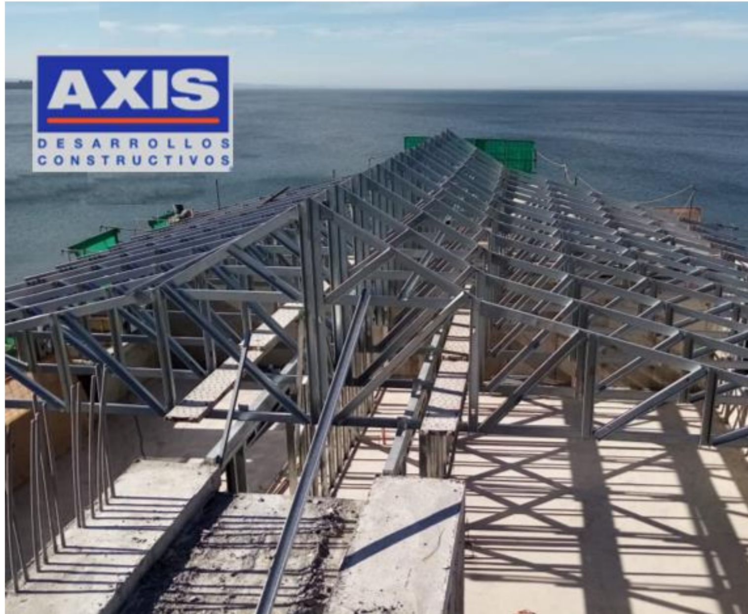
Montaje de elementos prefabricados (cerchas y tabiques)
