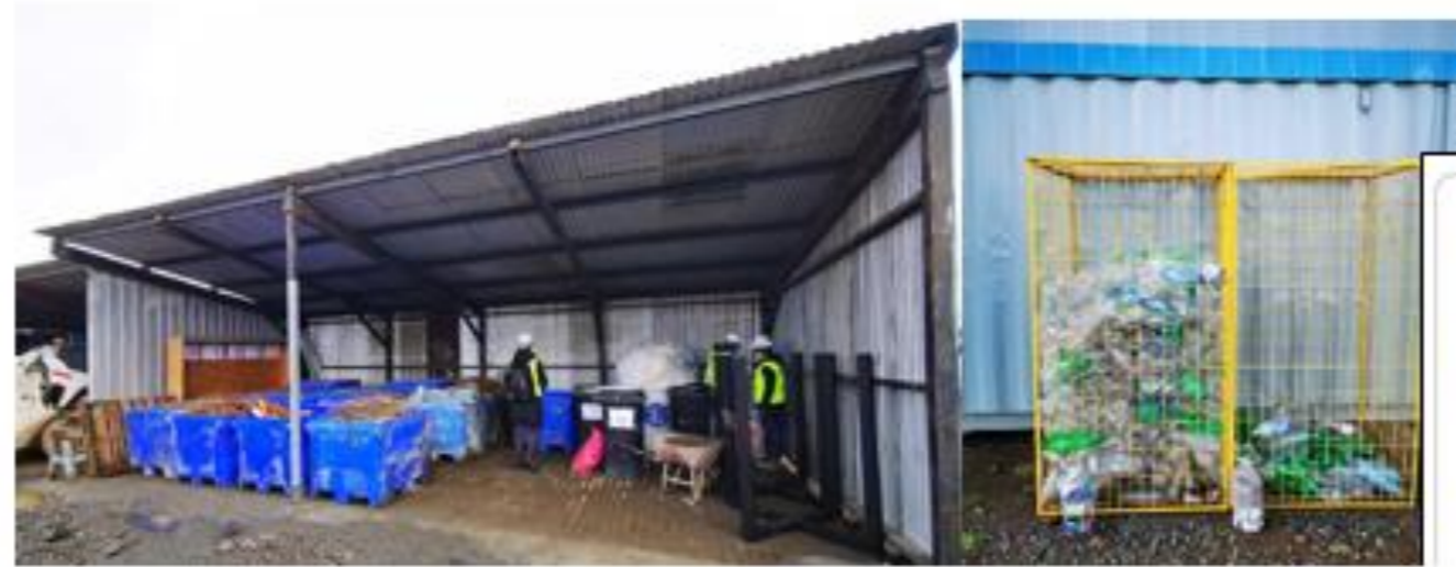
Sector de acopio de residuos
