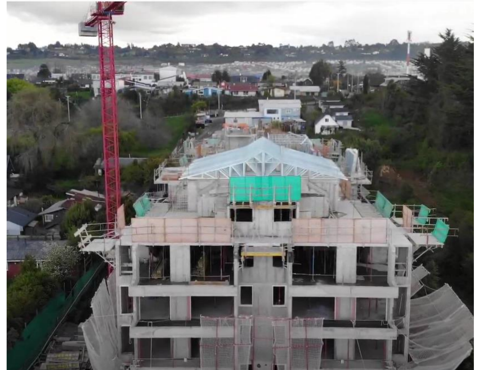
Montaje de elementos prefabricados (cerchas y tabiques)
