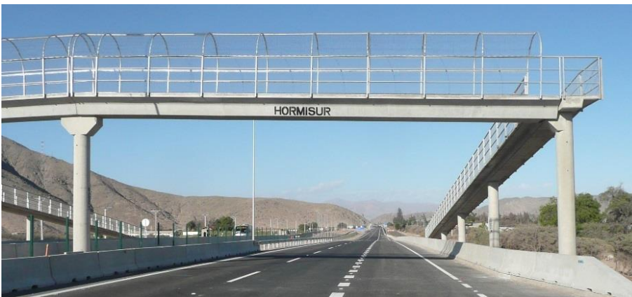
Pasarelas Tramo Santiago – Los Vilos
