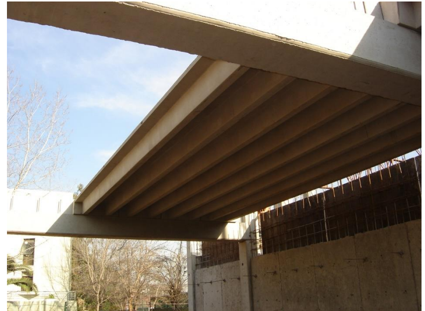
Recintos Escuela de Carabineros Constructora Desimco
