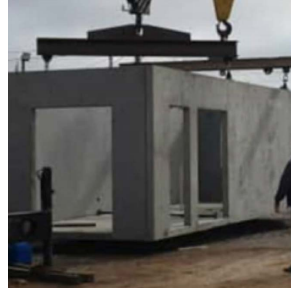
Módulos de hormigón
