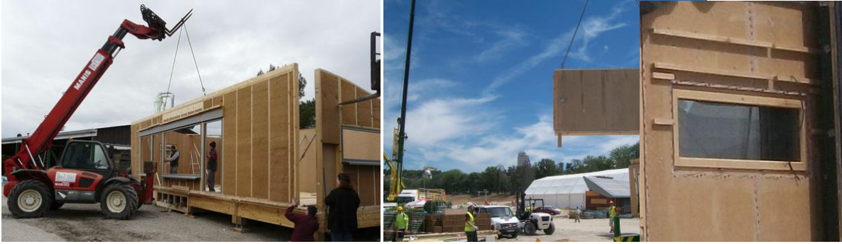
Casa NAPEVOMO – Montaje muros 2D, block técnico 3D y revestimientos interiores prefabricados 12 estudiantes y 3 montajistas – Habitable en 11 días
