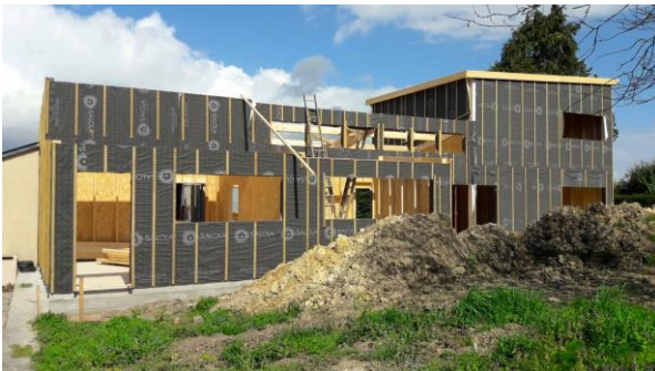
Casa ROUAULT– Revestimiento de muros y cubierta en obra
