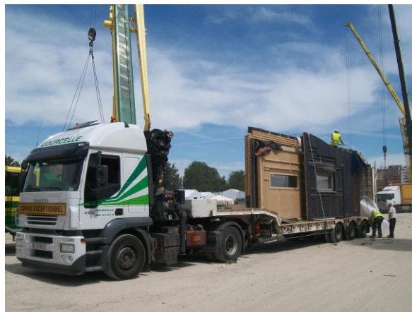
Casa NAPEVOMO – Transporte de muros terminados de Belin-Bélieat a Madrid 637 km en convoy excepcional
