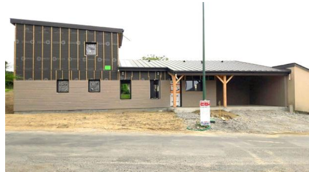
Casa ROUAULT– Revestimiento de muros y cubierta en obra
