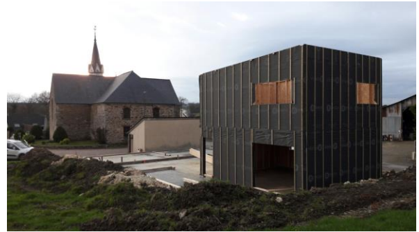
Casa ROUAULT – Montaje módulos 2D – 2 montajistas + camión grúa - día 1
