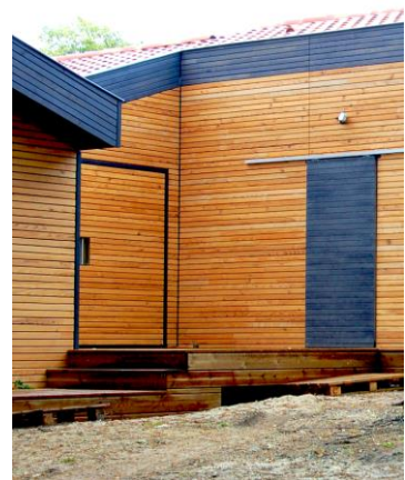
Casa SAN AGUSTIN– Montaje estructura y revestimiento – módulos prefabricados 2D - 4 montajistas + camión grúa
